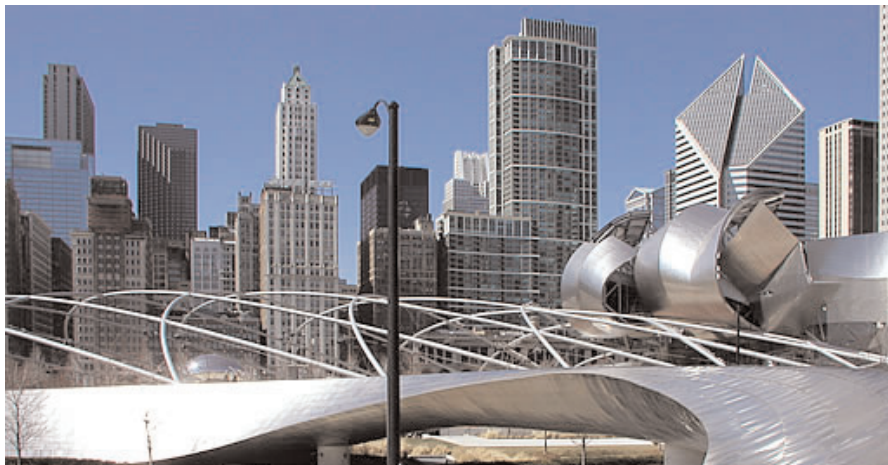
Structures construites (premier plan) en acier inoxydable de type 316 contenant du molybdène (Crédit photo IMOA).
