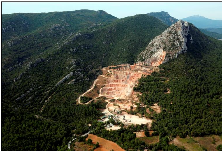
Figure 33 : Carrière de Candelon (Brignoles, Var) avec une production autorisée de 50 kt/an (Cliché : Provençale SA).
