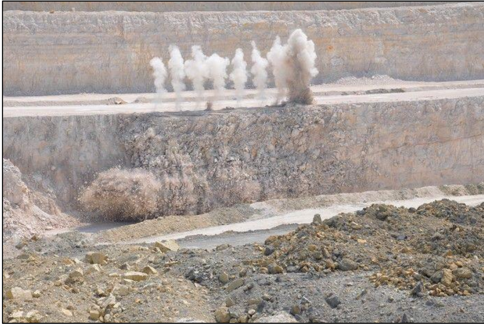
Figure 27 : Abbattage à l'explosif dans une carrière à ciel ouvert de calcaire, Carrière de Saint-Germain-sur-Meuse (Cliché : Philippe Martin, Didier Zany).
